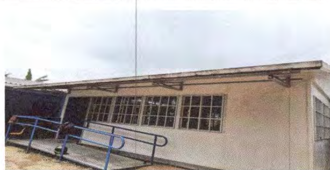
Foto 2: Mantenimiento a estructura de metal de ventana
