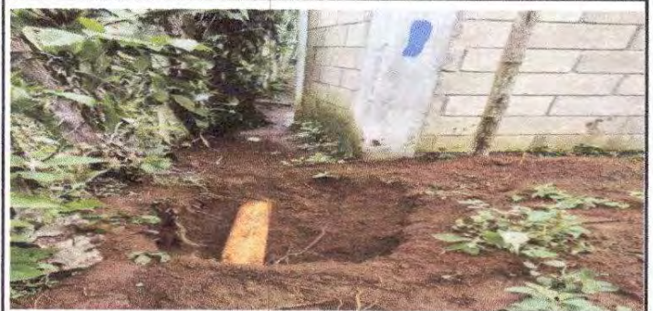
Foto 10: Sustitución de tubería PVC línea principal de aguas negras + Sustitución de caja de registro
