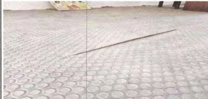
Foto 4: Sustitución de piso de torta de concreto (por PVC )
