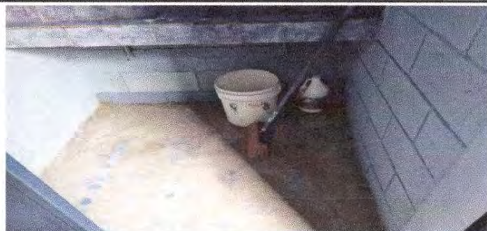
Foto 5: Sustitución de piso de cemento líquido (por ceramico antideslizante)
