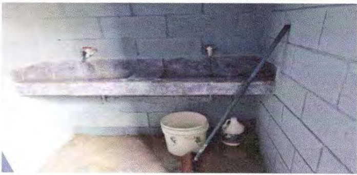
Foto 9: Sustitución de azulejo
