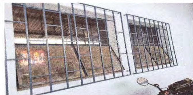
Foto 3: Sustitución de estructura de metal de ventana
