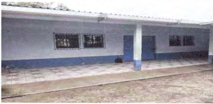
Foto 7: Pintura en muros interiores y exteriores
