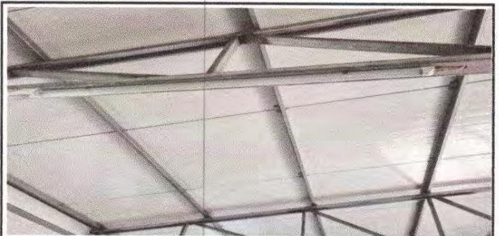
Foto 12: Sustitución de lamparas de 2 x 40
