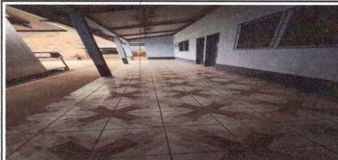
Foto 6: Sustitución de piso cerámico
