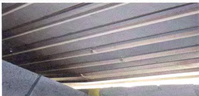
Foto 1: Sustitucion de lamina por lamina troquelada aluzinc calibre 26 + Sustitucion de elementos de fijacion
