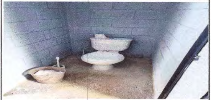
Foto 8: Sustitución de accesorios inodoro (contrallave, tubo de abasto) + Sustitución de inodoros
